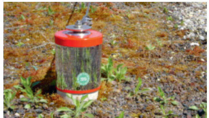
Abb. 25: Objektspezifische Anlagebeschriftung mit Prüfvignette
