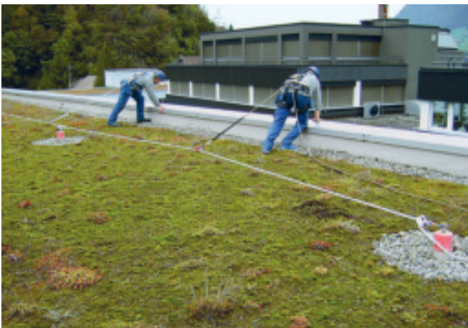
Abb. 10: Temporäres Seilsystem mit Karabinerhaken an EAP befestigt
